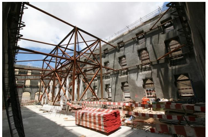
Figura 1 – Estrutura de contenção de fachadas interior.
