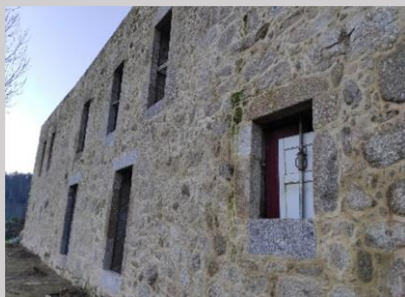
Quinta do Outeiro, Ponte da Barca - Reabilitação e Construção de Raiz
