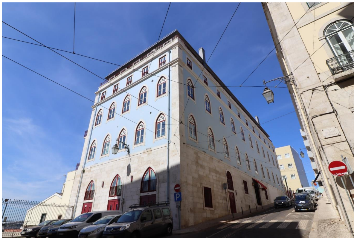
Figura 6 – Fachadas do edifício após a obra.
