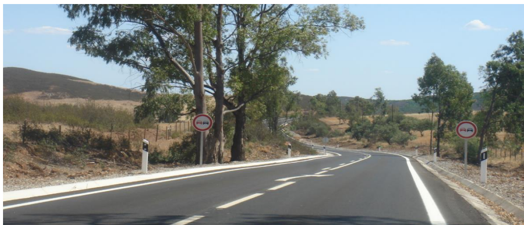
Figura 4 – Vista do pavimento da EN370 próximo de Avis, com mistura betuminosa com borracha, após 5 anos de construção.
