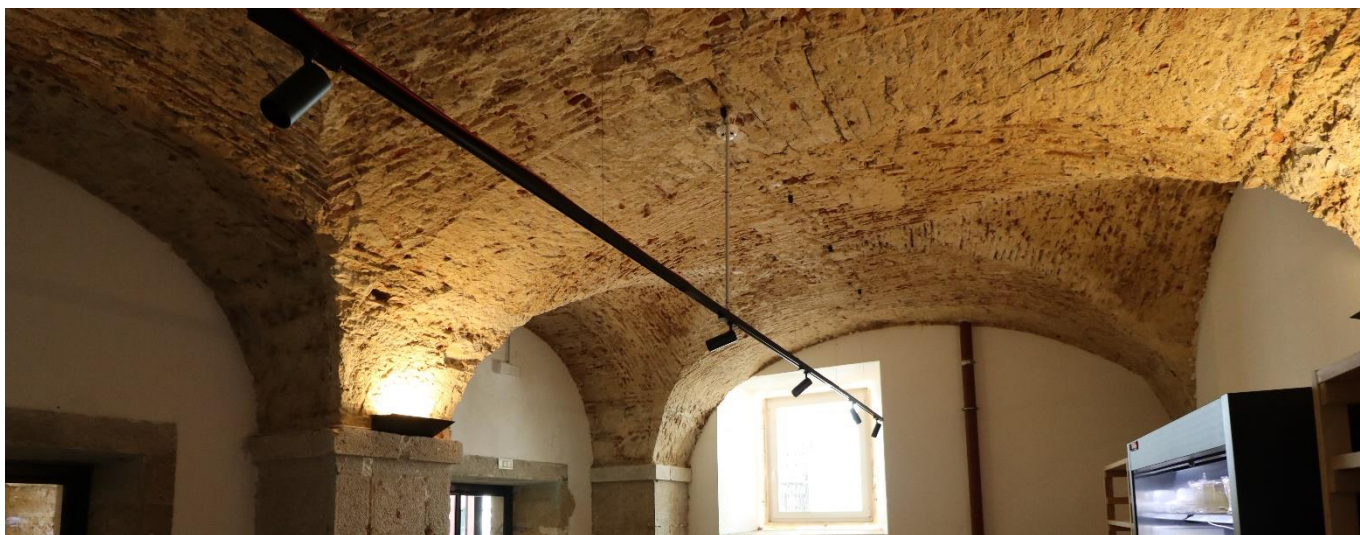
Figura 5 – Abobadas recuperadas do piso 0.
