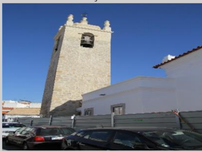
Igreja Matriz de Loulé, Loulé - Reabilitação, Conservação e Restauro
