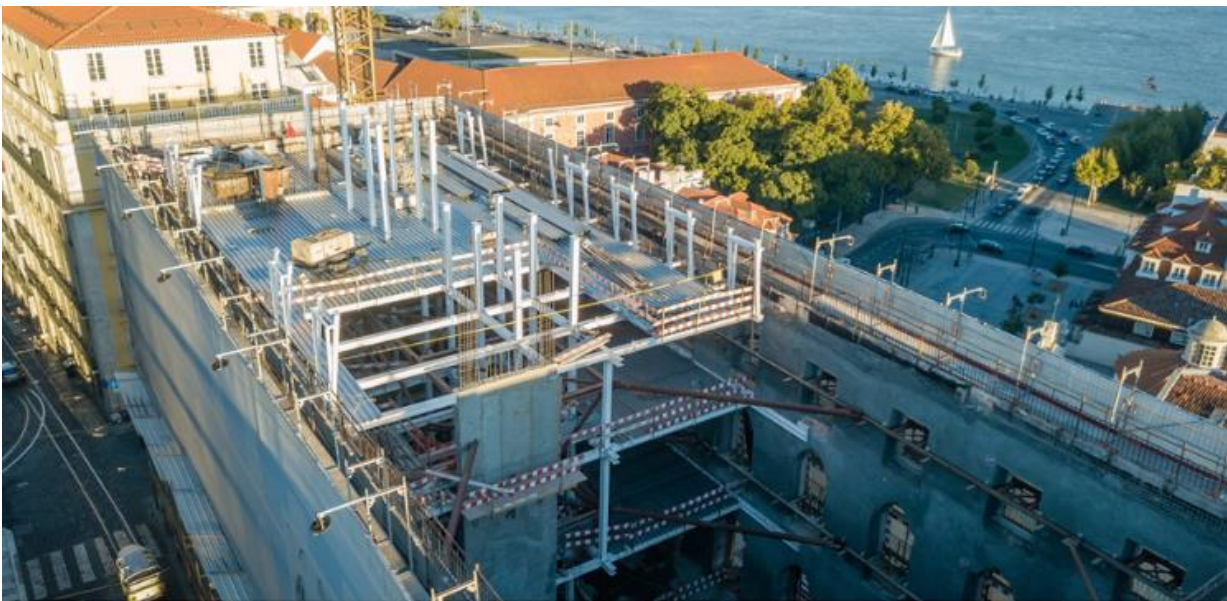
Figura 4 – Vista de obra.
