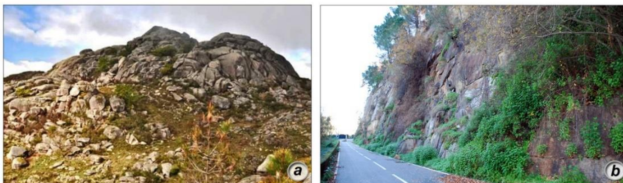
Figura 1 – Cenários de queda de blocos: a) vertente natural b) talude rochoso adjacente a via rodoviária.
