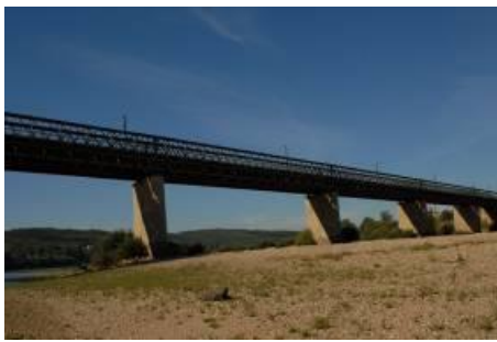
Figura 2 – Ponte da Praia do Ribatejo sobre o Rio Tejo: monitorização de deslocamentos durante ensaios de carga através de fotogrametria.
