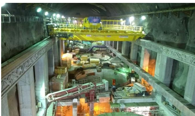
Figura 7 – Hidroelétrica de Ituango: vista do interior durante o processo de recuperação.
