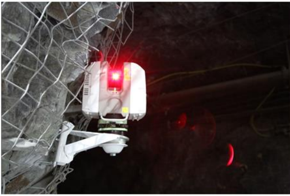
Figura 1 – GML instalado sobre suporte para monitorio contínuo.
