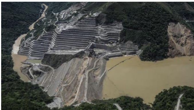
Figura 5 – Hidroelétrica de Ituango: vista aérea.
